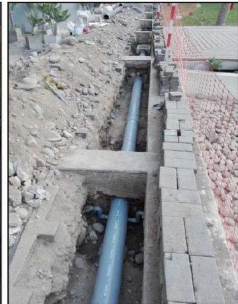
**Figura 8.** Instalación de tuberías dentro de zanja en paso peatonal del Pabellón A.
