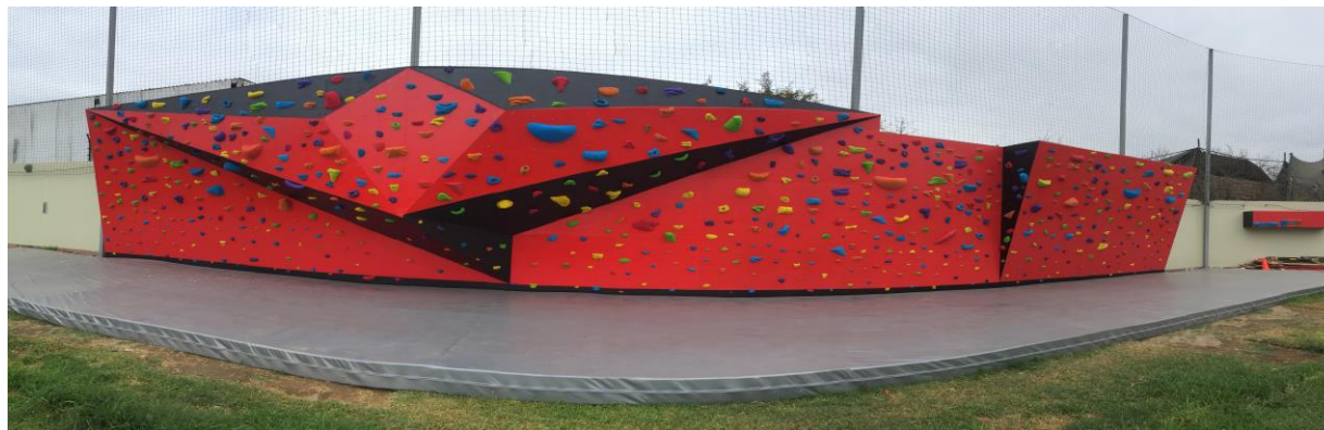
Construcción de Palestra (2018)
