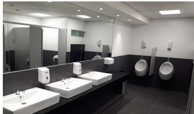
Remodelación de Baños del 1er al 7mo piso A (2018)
