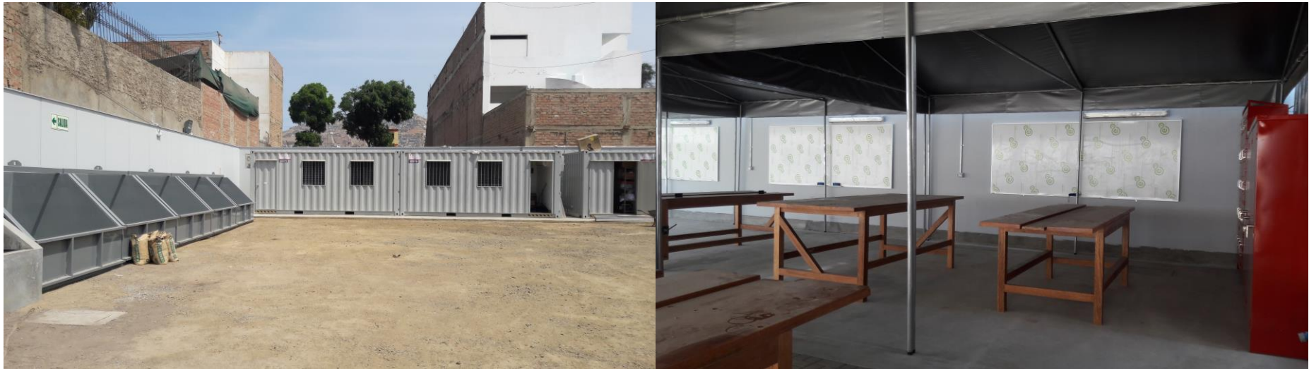
Construcción de “Taller de Construcción” en Playa de Estacionamiento Eleuteria (2017)
