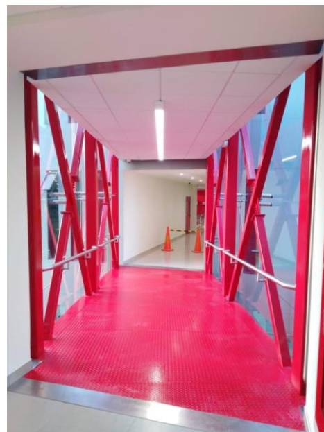
Construcción de Puente Metálico que conecta el 6to piso del Pab A con el 7mo piso del Pab B (2019)
