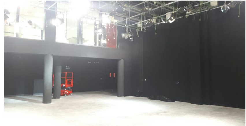
Construcción de Set de TV 1er piso B (2018)
