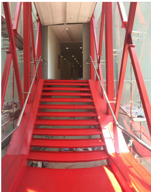
Construcción de Puente Metálico que conecta el 3er piso del Pab A con el 4to piso del Pab B (2017)
